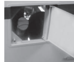
TANQUE DE URÉIA
